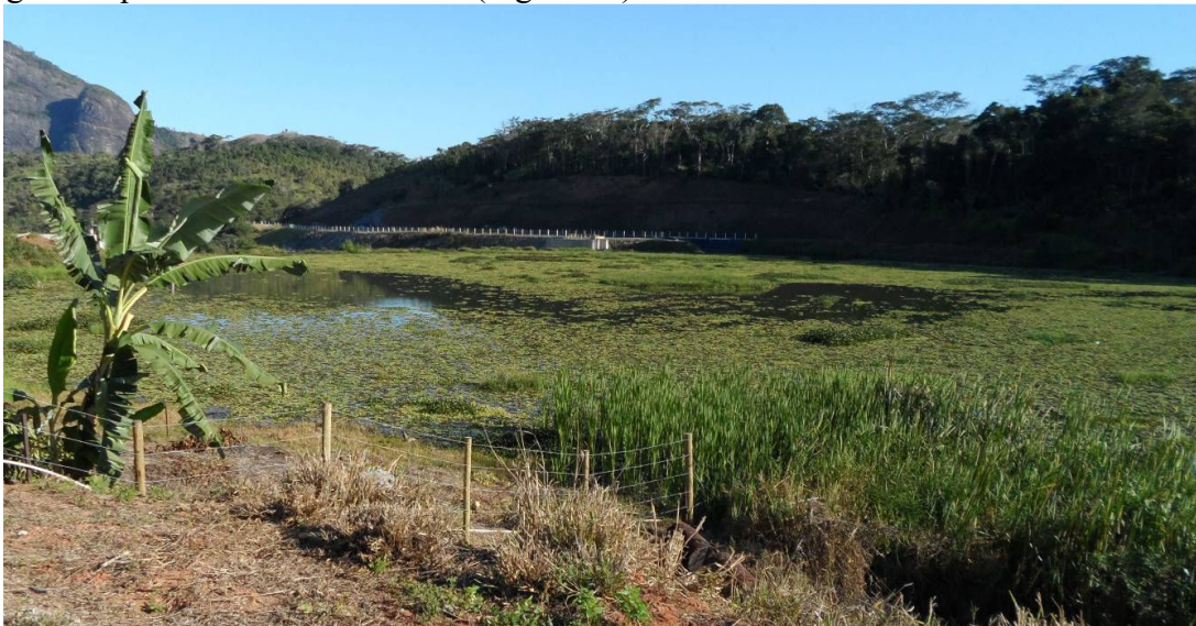
Figura 08: Presença de macrófitas no reservatório da PCH Pedra do Garrafão.
